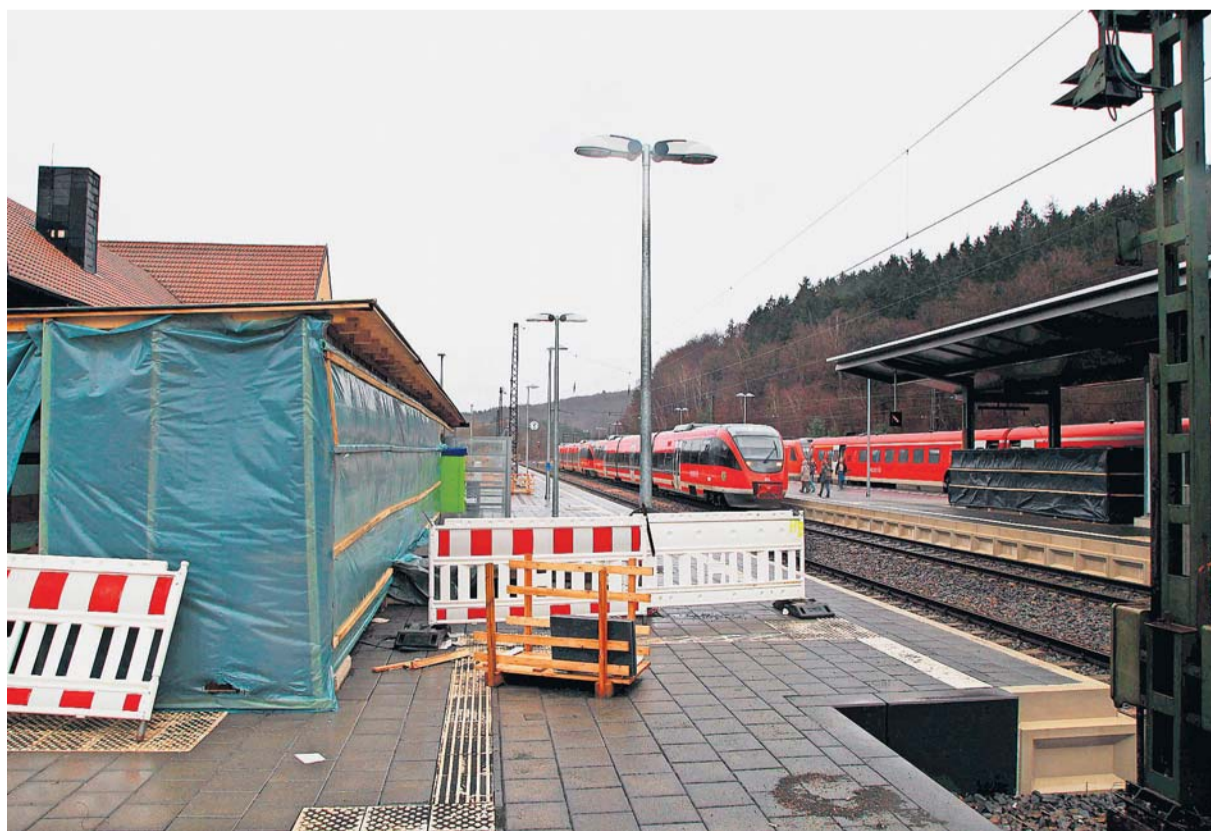
Die Bauarbeiten an den Gleisen sind bereits voll im Gange. FOTO: B & K
